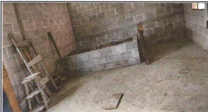
Foto 7: MANTENIMIENTO DE PISO RUSTICO A PISO CERAMICO DE COCINA.
