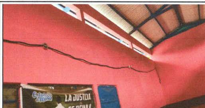
Foto 2: MANTENIMIENTO DE SISTEMA ELECTRICO
